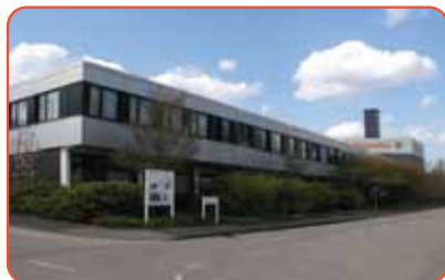
位于德国的集团公司总部
